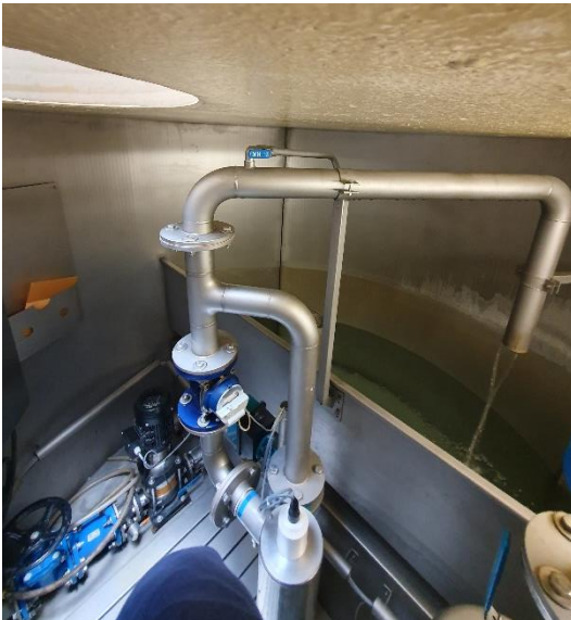
rechts: Brunnenstube der Quellen Dachsberg unten: Quellwasserpumpwerk Dachsberg
