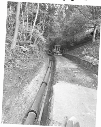
Mai 2026/Wasserversorgung Eglisau
