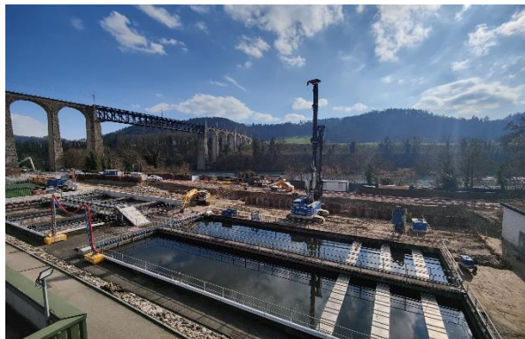
rechts: Stand der Arbeiten 17. März 2025
