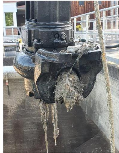
wann hat auch diese Pumpe ihre Grenze erreicht. Das heisst, die Pumpe muss ausgebaut, zerlegt und von den Fremdkörpern befreit werden.
