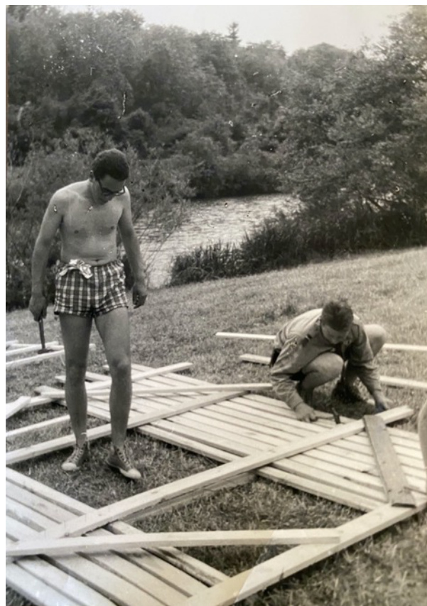
Die Plattform wird gezimmert
