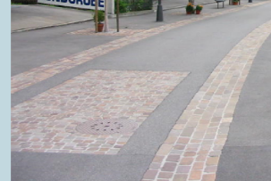
Belagswechsel Beispiel Zweisimmen
