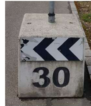
Betonquader als Fundament für Stelen und vertikale Elemente
