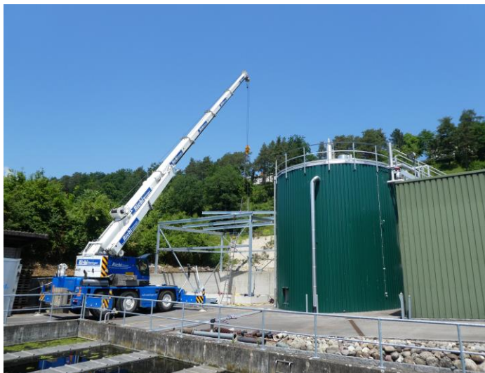
Aufbau mit mobilem Kran
