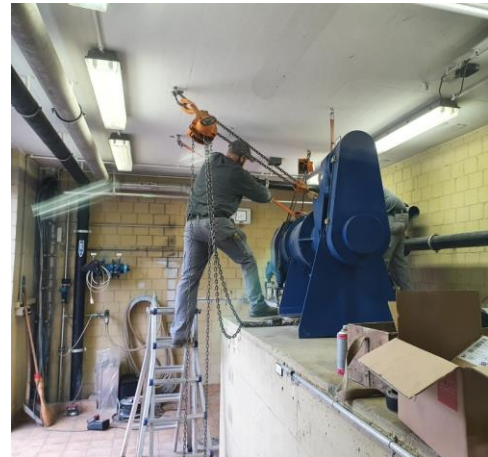
Demontage der alten Strainpresse
