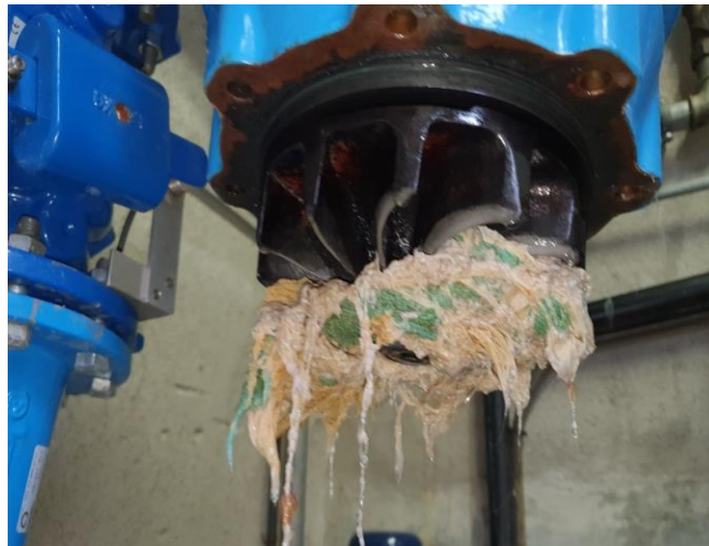
Das Bild zeigt abgenutzte Schaufelräder mit anhaftender Verstopfung
