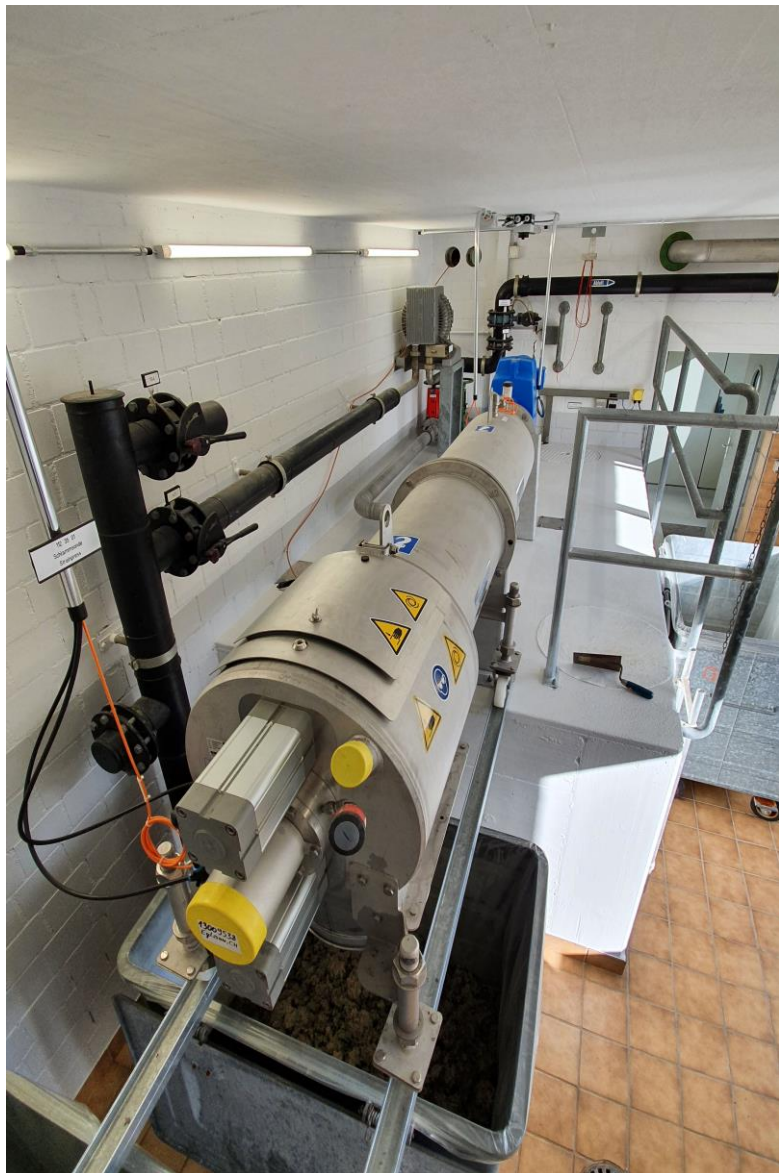
Strainpresse zur Schlammsiebung
