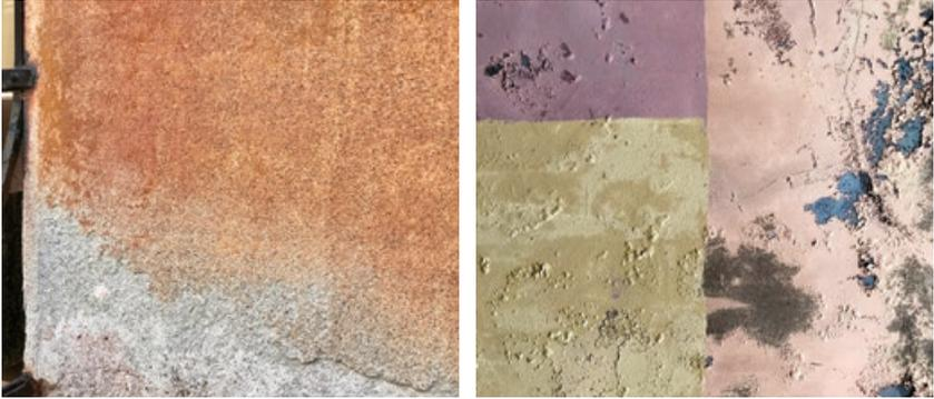
*Abb. 6* Rund fünfzigjähriger, mineralisch gebundener Kalkputz und Kalkfarbanstrich – rund siebenjähriger, kunststoffgebundener Anstrich auf verputztem Mauerwerk (von links nach rechts). Mineralisch gebundene Putze und Farbanstriche altern ausgesprochen langsam und gleichmässig, während kunststoffgebundene Anstriche oftmals schon nach wenigen Jahren durch Abplatzungen, Fäulnis und Zersetzung geprägt sein können.
