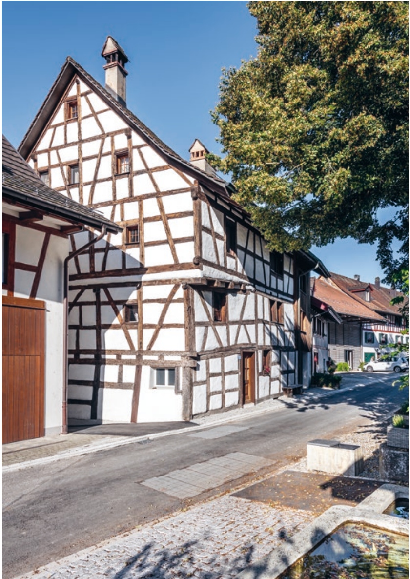
Abb. 12 Burg, Burgstrasse. Blick von Osten. Haus Burgstrasse 22/24 (Vers.-Nr. 399).
