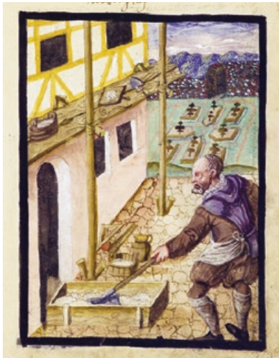
Abb. 8 Der Tüncher Nicolaus Weidenhöffer bei der Arbeit. Mit dem Mörtelspaten mischt er im Mörtelkasten den Putz. An Werkzeugen sind sichtbar: Kellen und Eimer mit Putz, ein Winkel, Pinsel und ein Krug mit Farbe. Buchmalerei, 1592. Handbuch der Mendelschen Zwölfbrüderstiftung, Nürnberg, Amb. 317b.2° Folio 54 recto, Mendel II.
