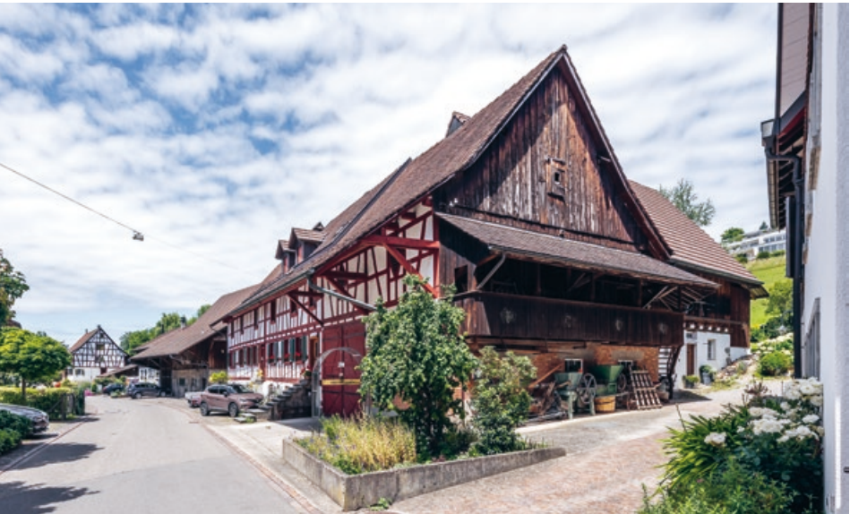
Abb. 14 Wiler, Wilerstrasse. Blick von Osten. Haus Wilerstrasse 14 (Vers.-Nr. 478).
